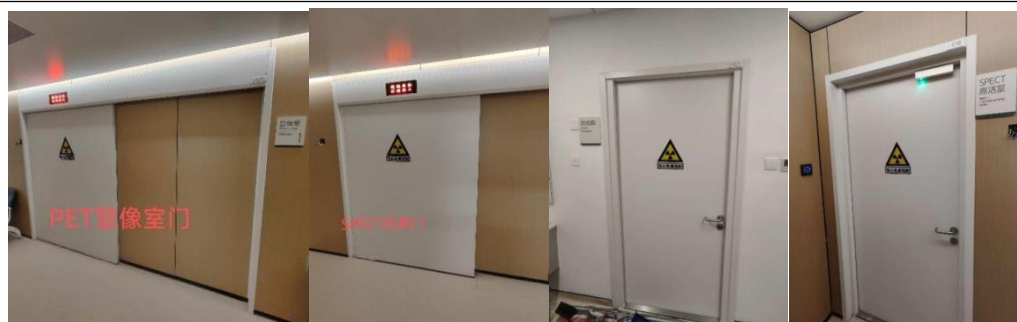
机房门外警示标识、工作状态指示灯等
