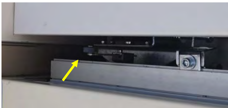
2 见 DSA 机房患者防护门上方的门灯关联装置
