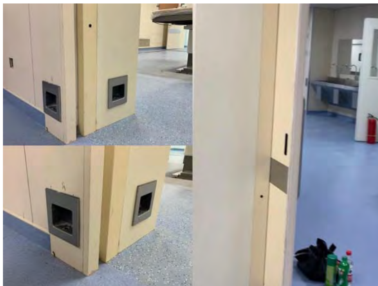
2 见 DSA 机房防护门脚踢式门控开关
